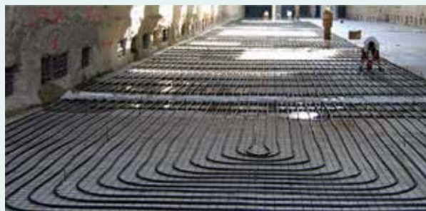
Erdwärmekollektoren unter der Bodenplatte (Quelle: iC consulenten)
